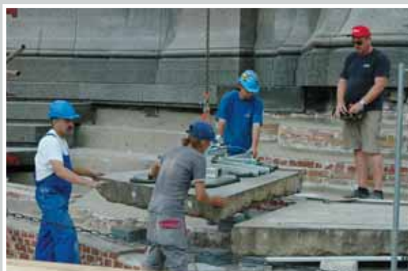
10. AUGUST 2009 Einpassen der Granitplatten mit Vakuum-Kran auf dem sanierten Fundament.
