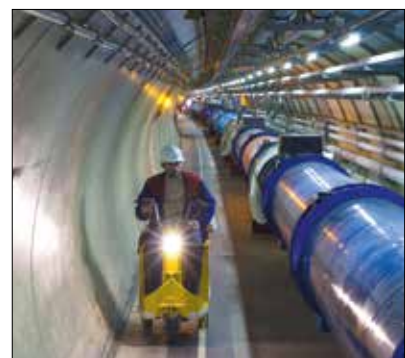
LHC-Tunnel am CERN: Umfang: 27 km Betriebstemperatur: -271,25 °C
